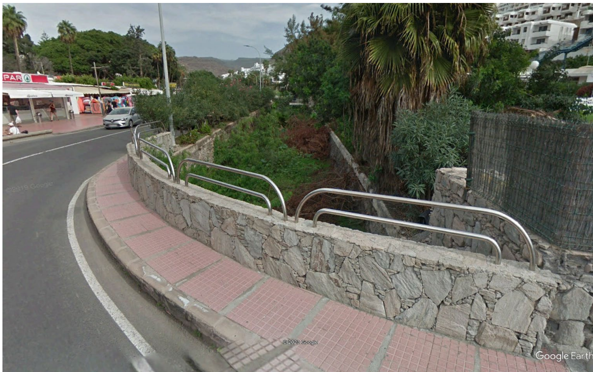
Figura 34. Vista del barranco aguas arriba del puente 10.
