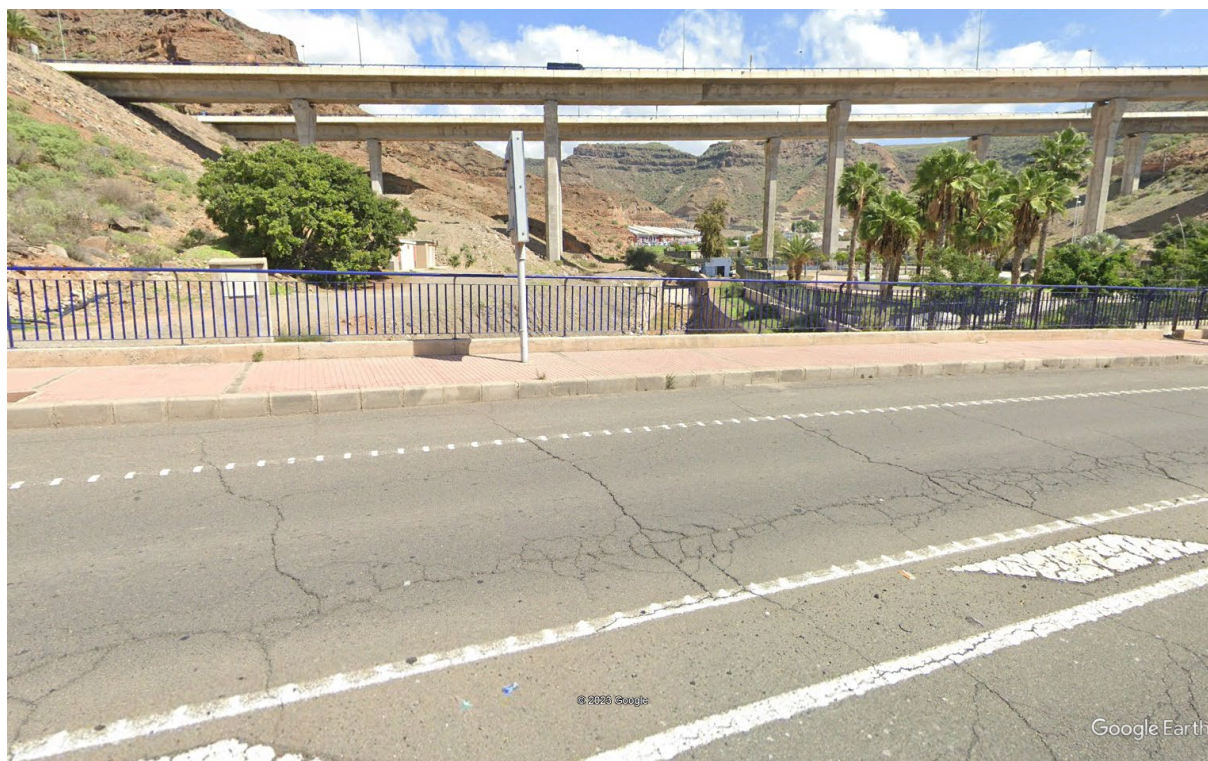
Figura 16. Vista del barranco aguas arriba del puente 4.
