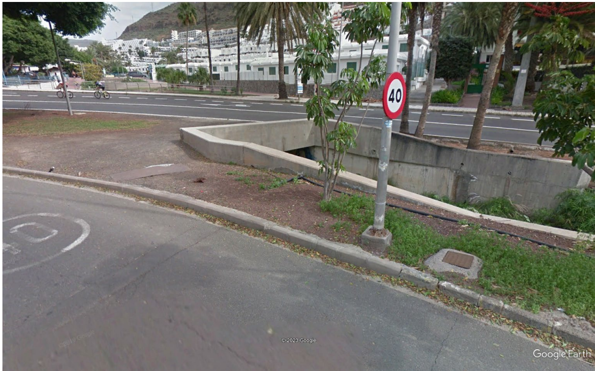
Figura 28. Vista de la zona aguas abajo del puente 7, desde margen derecha.
