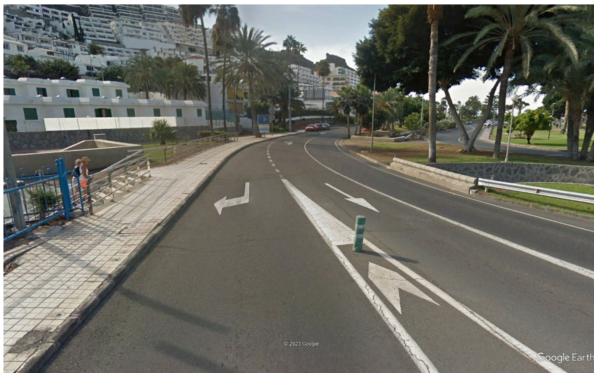
Figura 26. Vista de la zona del puente 7 sobre la carretera de Mogán.
