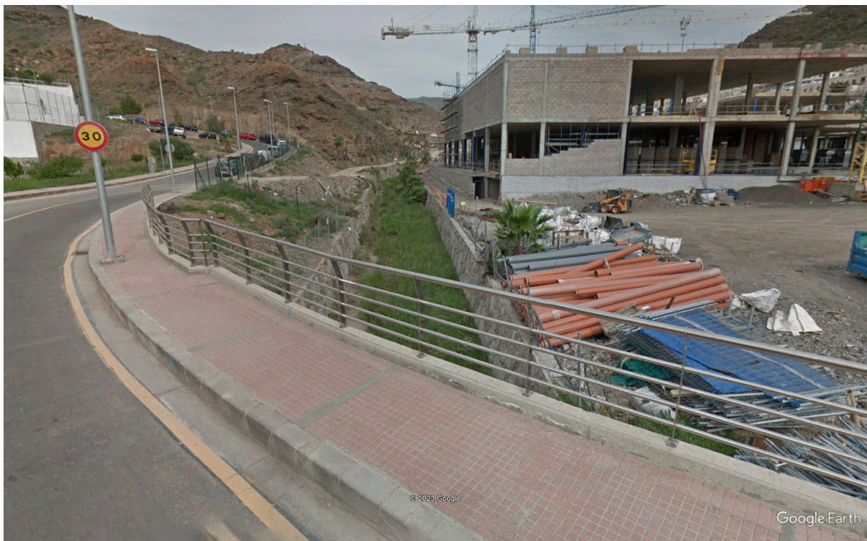
Figura 20. Vista del barranco aguas arriba del puente 5 (12/2018).
