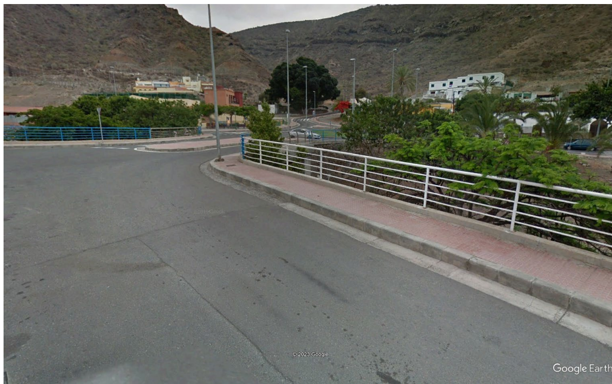
Figura 10. Vista de la zona de aguas arriba del puente 2, sobre margen izquierda.
