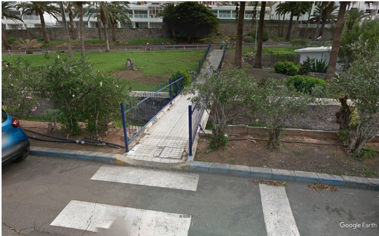
Figura 30. Vista de la pasarela peatonal 1, puente 8.
