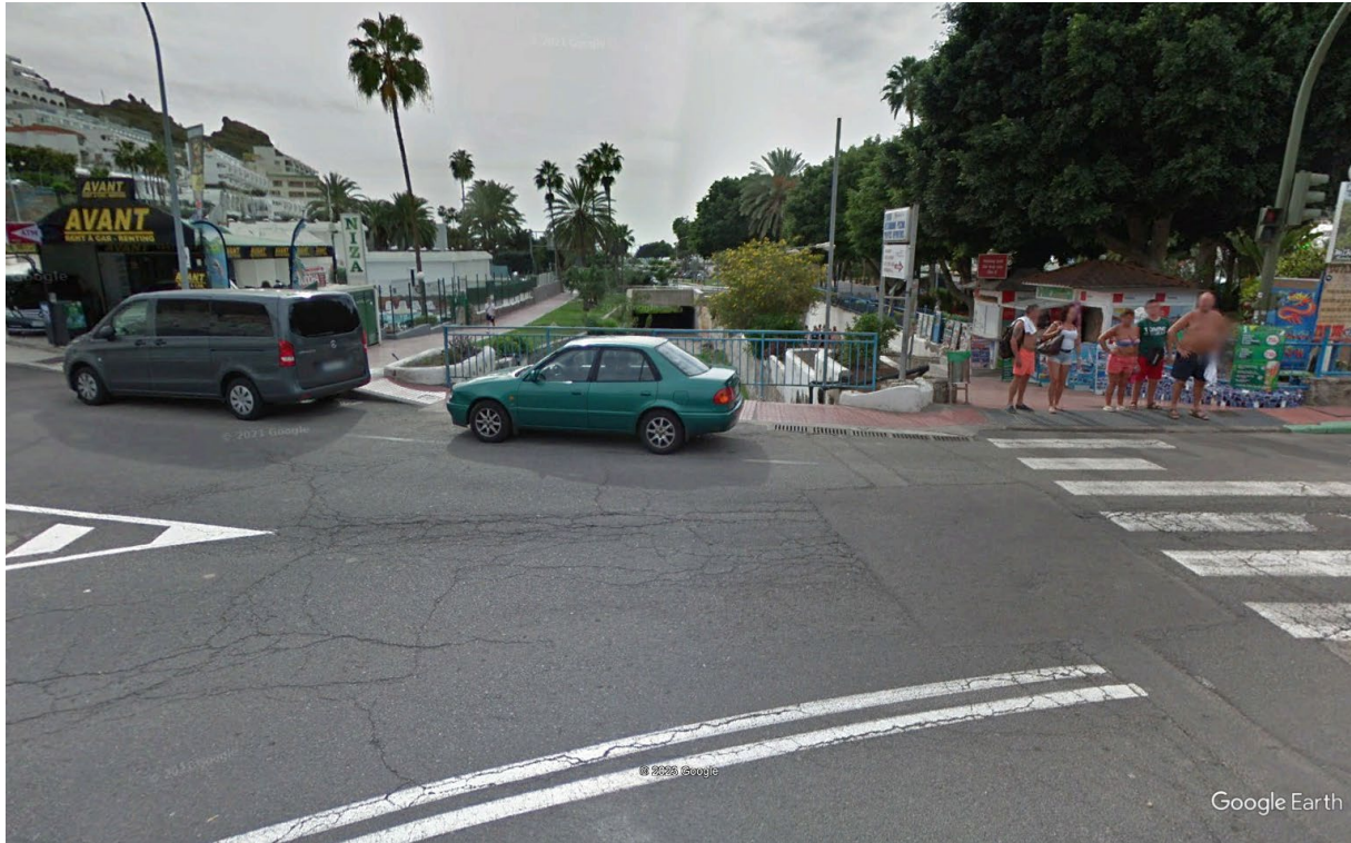
Figura 23. Vista del barranco aguas abajo del puente 6.
