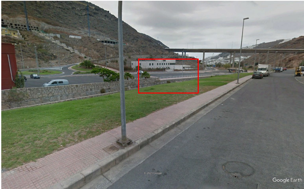
Figura 64. Zona inmediatamente aguas abajo del Parque de Bomberos.
