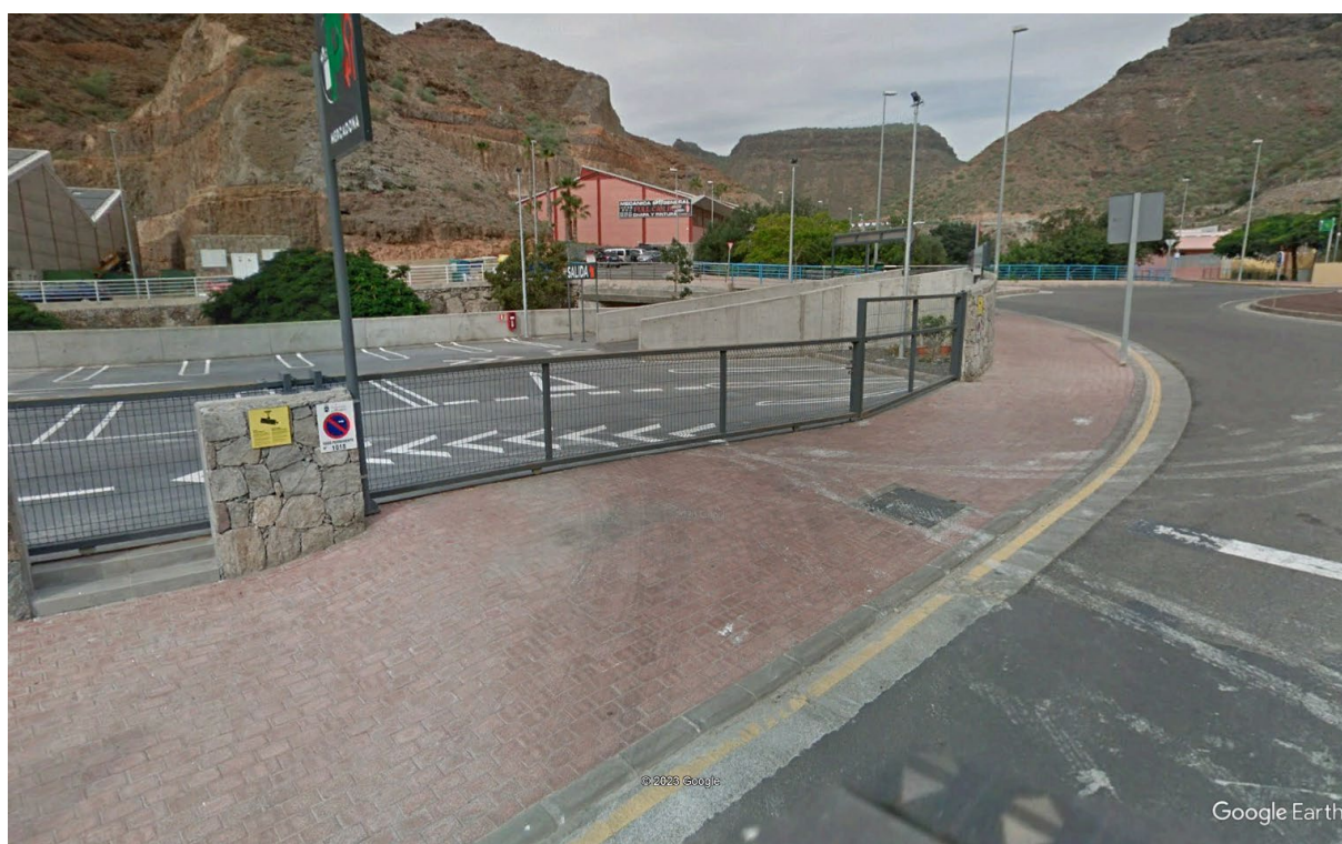
Figura 11. Vista de la zona de aguas abajo del puente 2, sobre margen izquierda (12/2018).
