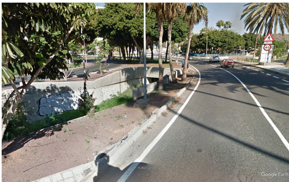
Figura 27. Vista de la zona aguas abajo del puente 7, desde margen izquierda.
