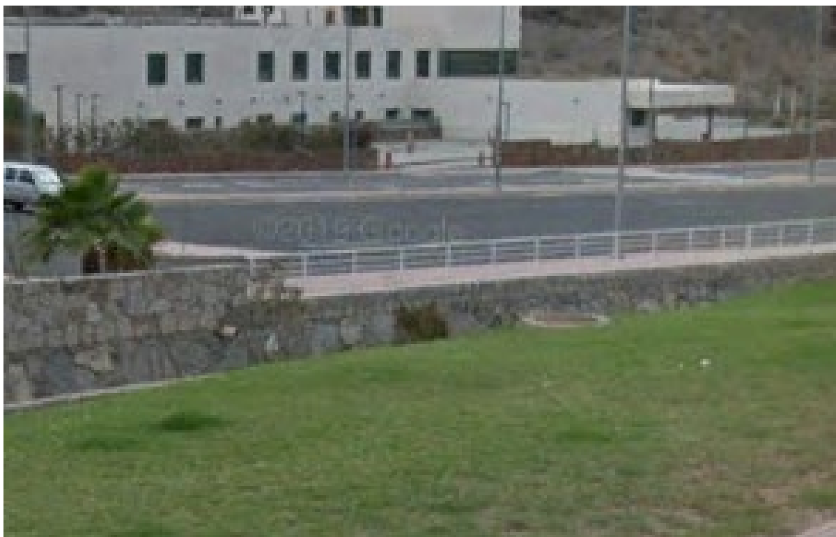
Figura 65. Detalle de la zona inmediatamente aguas abajo del Parque de Bomberos, donde se ve la disminución de altura del cajero de margen izquierda.
