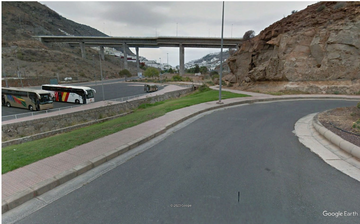
Figura 14. Vista de la zona de aguas arriba del puente 3.
