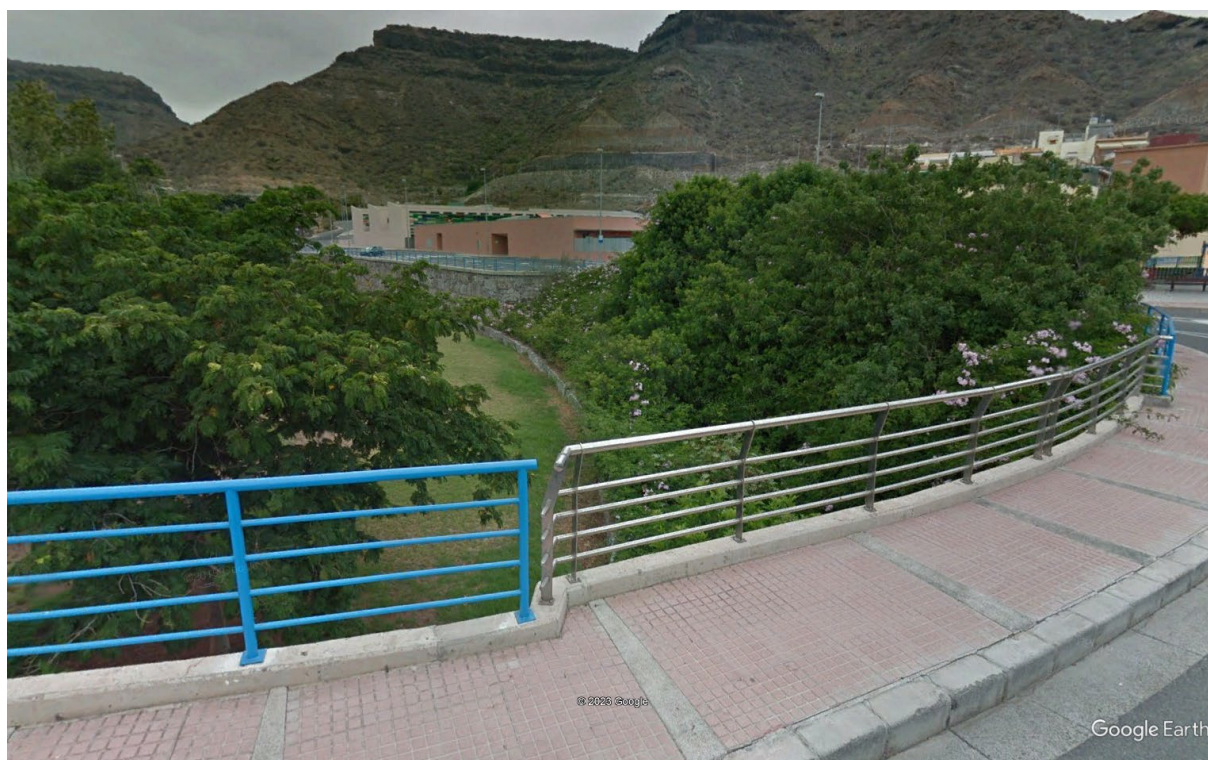
Figura 9. Vista de la zona de aguas arriba del puente 2.
