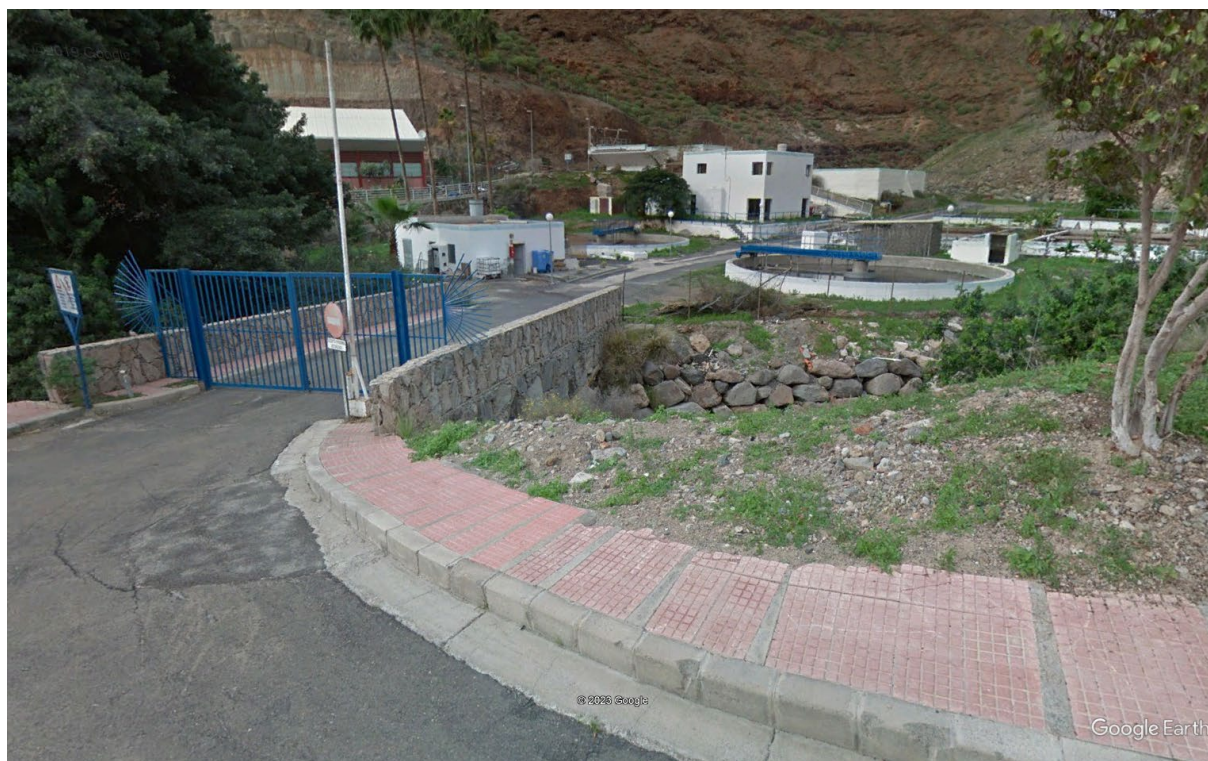
Figura 6. Vista del puente 1 junto a la ETAP.
