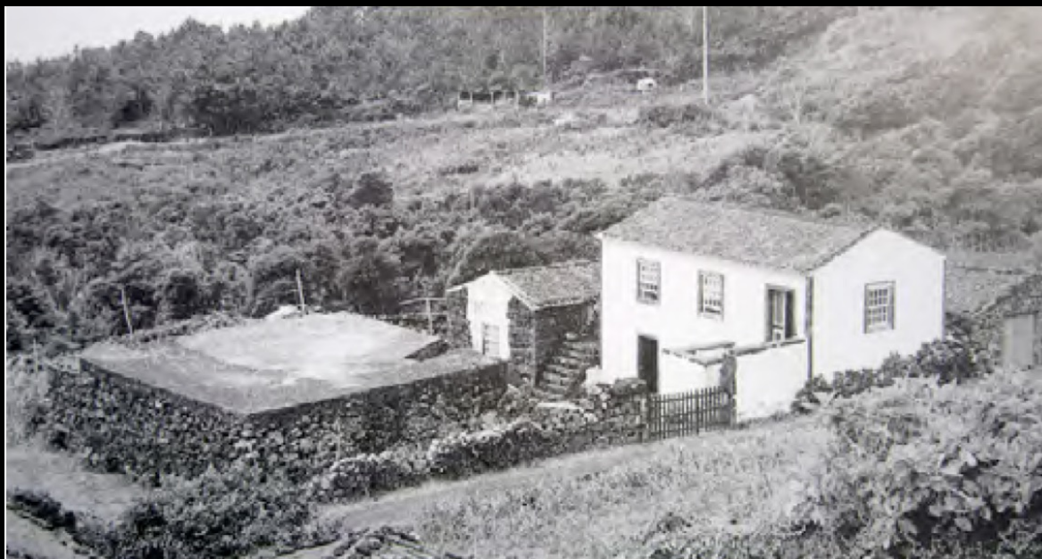
de Mós; (direita) Habitação com caleira integrada na fachada para recolha de água. Mendiga [14]
