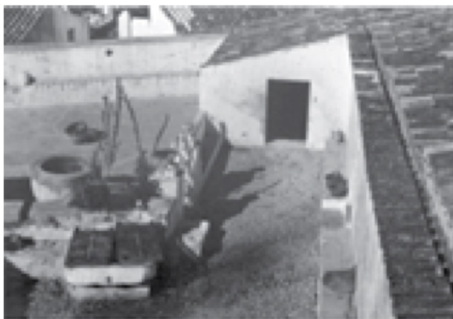
Figura 19 - Habitação com sistema de recolha de águas pluviais. Tunes, Silves [14]
