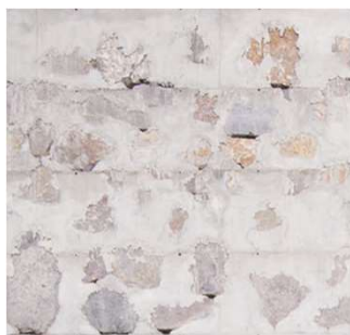
Betão ciclópico com matéria prima local
